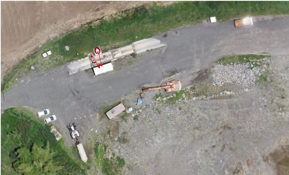
Figure 18. Localisation des extincteurs au sein du site
